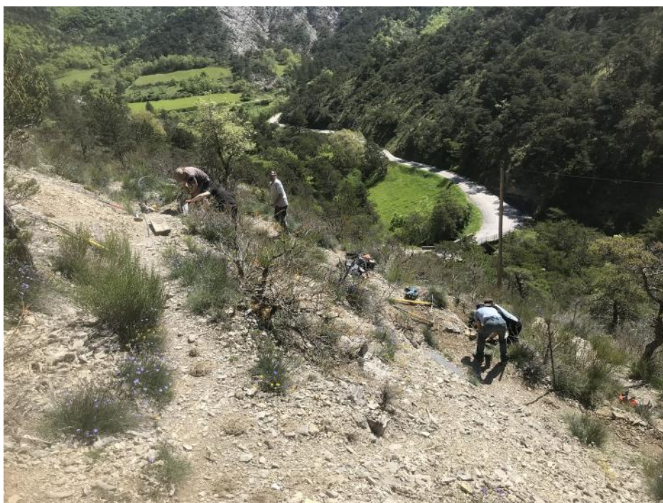
Sentier Rampillon en cours de réhabilitation
